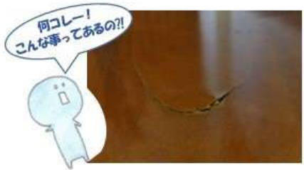
部分補修する箇所を養生テープで囲う
