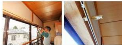
Wカーテンレールを取付け
