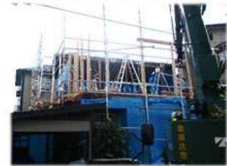
2階は和室6帖2間だったお宅が、柱だけになり床板面積も広げ、下屋だった場所には柱が立った
