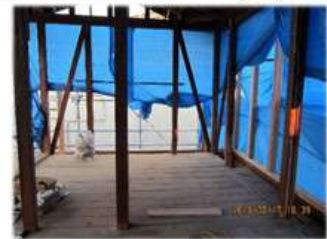
2階は和室6帖2間だったお宅が、柱だけになり床板面積も広げ、下屋だった場所には柱が立った
