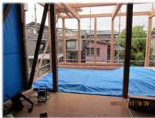
既存の柱と新設された柱が混在
