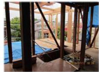
既存の柱と新設された柱が混在
