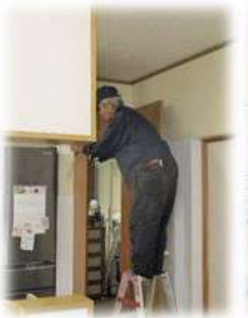
何も無いところから壁を作る作業 下地の場所を確認しながら、印をつけていく
