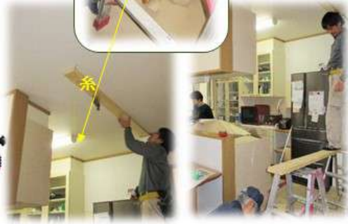
柱を垂直に建てる為の作業 『下げ降り』を使う
