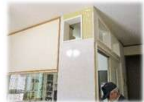
ボードの上にキッチンパネルを施工
