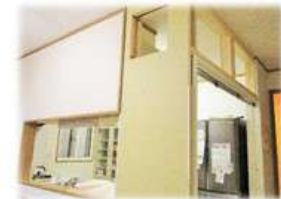
開口部を残してボードを貼る
