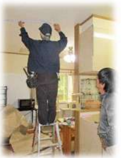
何も無いところから壁を作る作業 下地の場所を確認しながら、印をつけていく
