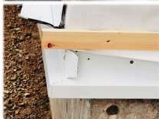
まるで折り紙のように板金をカットしており曲げていきます
