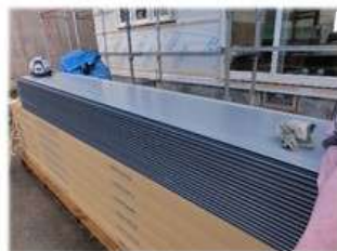
貼る前の外壁材 これをサイズにカットして貼っていく
