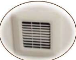
各部屋の天井にある冷暖気の出口
