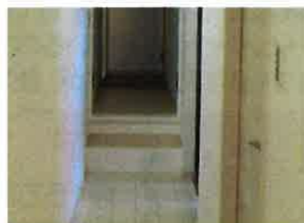
新設した階段
