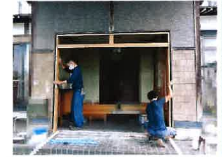
新規サッシ枠を設置
