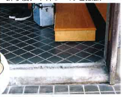
研り後、下枠レールを撤去
